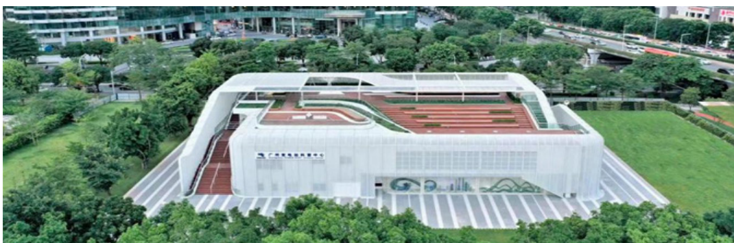
图6 南方电网广州110千伏猎桥变电站景观图
