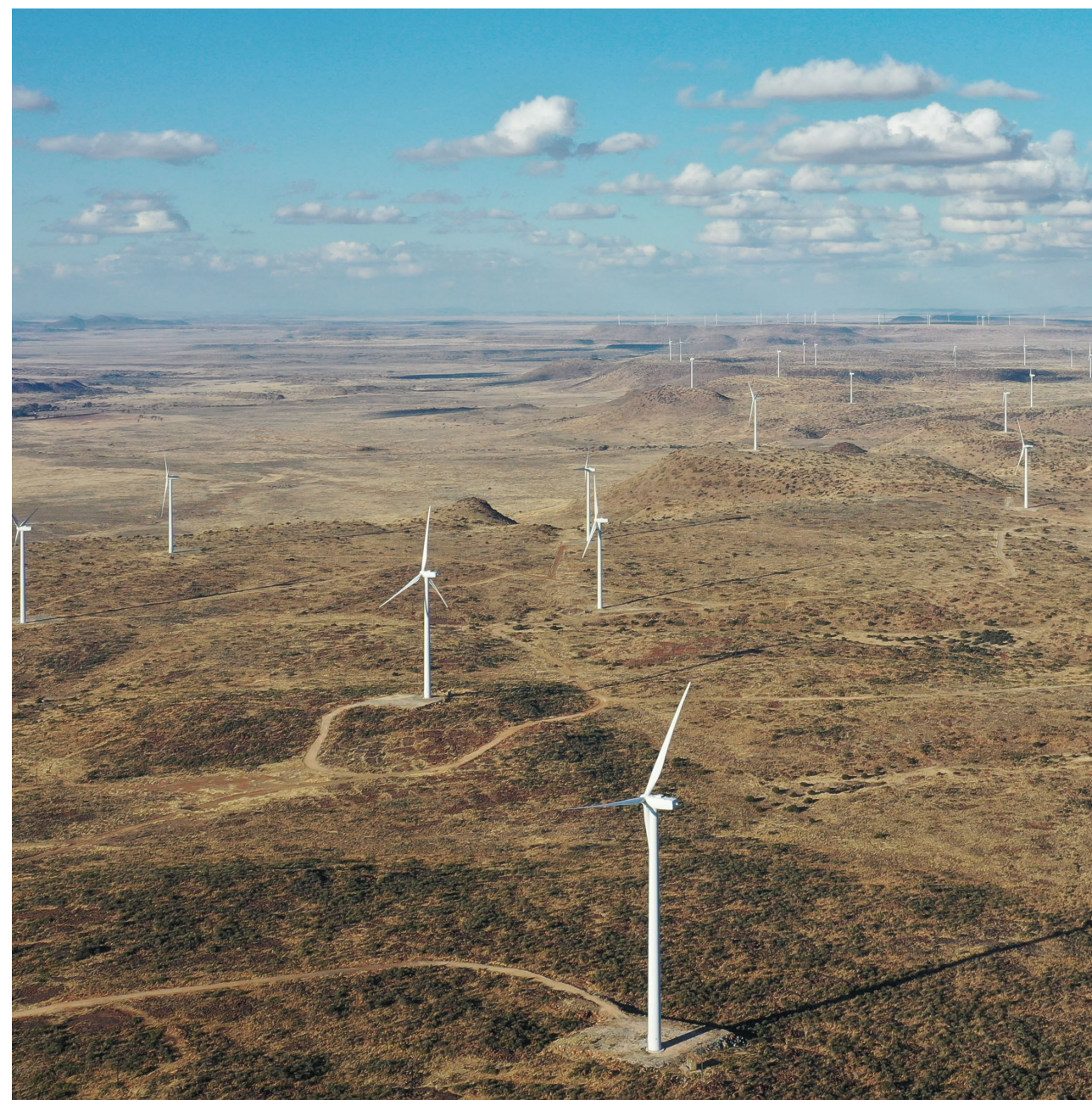
(龙源德阿风电项目现场)
