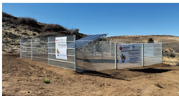
(图为龙源南非援建的地下水供应项目)
