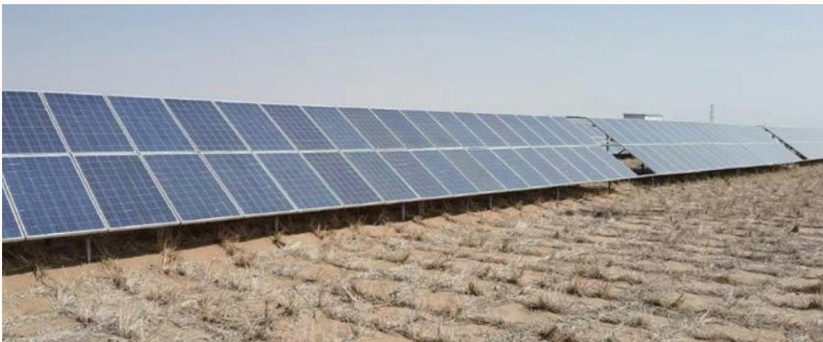
图 6.5 光伏电站的草方格治沙工程措施（摄于 2022 年 3 月）
