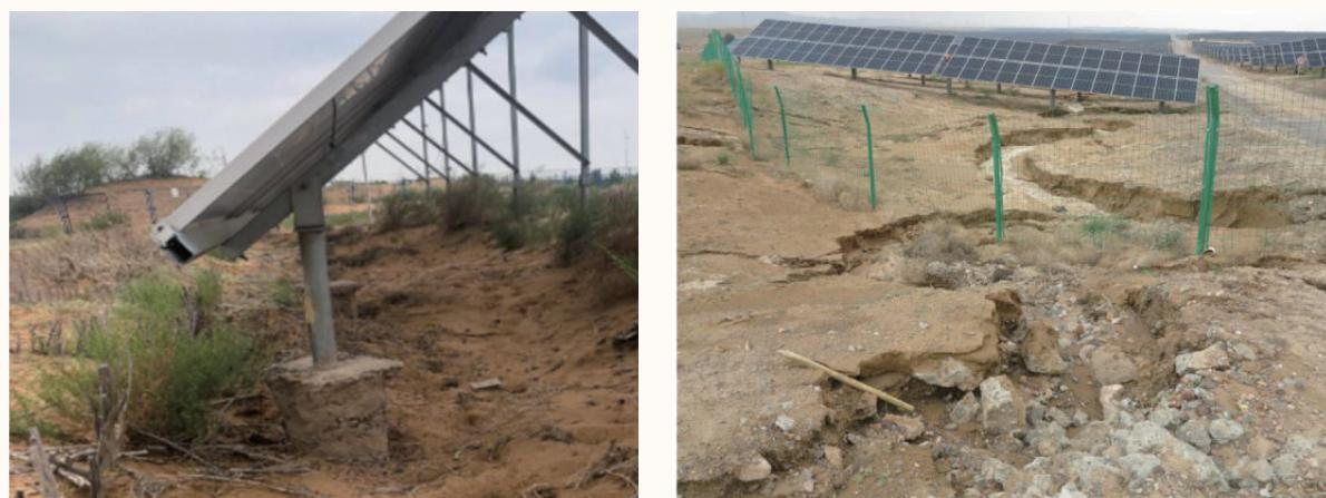
c 光伏板狭管效应造成桩基裸露
