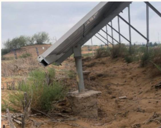
c 光伏板狭管效应造成桩基裸露
