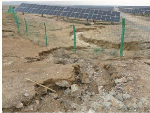
d 极端降雨造成的土壤侵蚀
