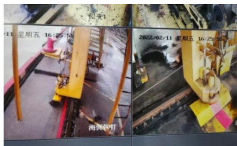
卸船机锚定装置 5G 监控
