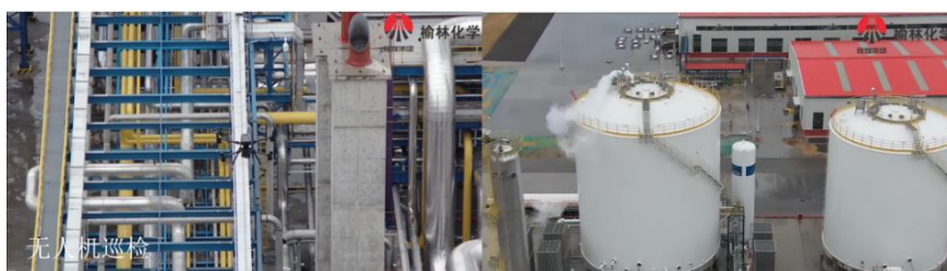
无人机巡检管廊及罐顶仪表阀门
