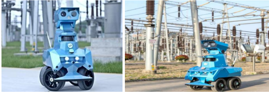
变电站 5G 机器人巡检
