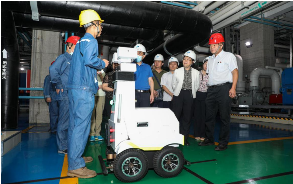
5G+轮式/挂轨式巡检机器人应用
